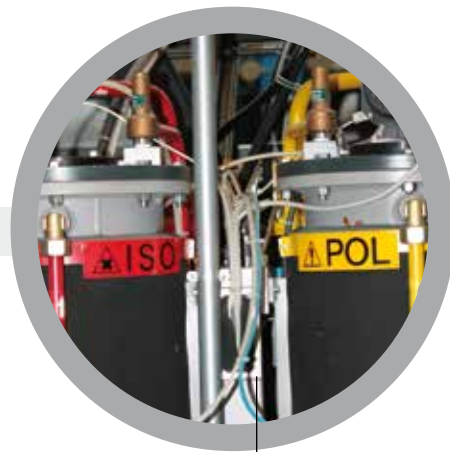
Particolare dell'impianto di schiumatura Detail of the foaming machinery
